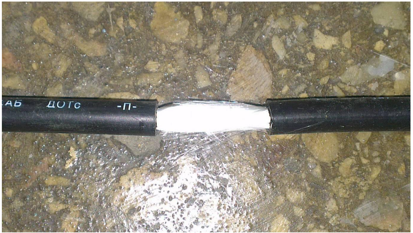
1.3. Проникновение воды в кабеле ДПО с междумодульным гидрофобным наполнителем (оболочка удалена после всех испытаний):
